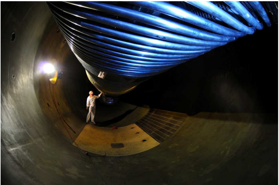
Blick in den Beschleunigertank
